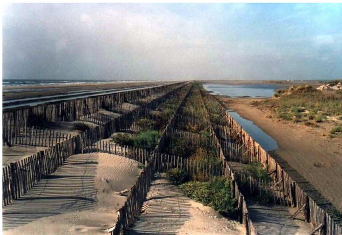
Figure 15 : Photographie de la Flèche de la Gracieuse (13), vue de l'ouvrage ; ensablement des casiers de ganivelles et colonisation par la végétation en façade terrestre
