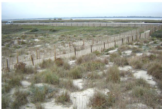
Figure 27 : Photographie d'un accès encadré par deux lignes de ganivelles avec géotextile de protection, Canet-en-Roussillon (66)
