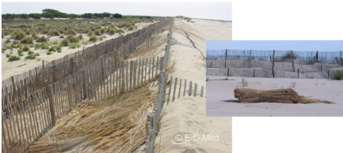
Figure 20 : Photographies des dunes du Grau du Roi (30), paillage du revers d'un cordon dunaire reconstitué et gerbe de *Phragmites australis*
