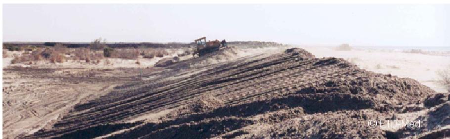
Figure 13 : Photographie de la Flèche de la Gracieuse (13), talutage mécanique des versants du bourrelet sableux, corps de la future dune
