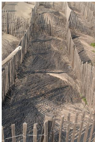
Figure 22 : Photographie de la dune du Grau du Roi (30), paillage intact
