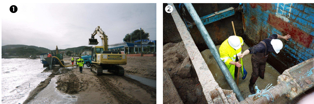
Figure 2 : photographies des travaux de mise en place du système Ecoplage® sur la plage d'Agay, commune de Saint Raphaël, Var
