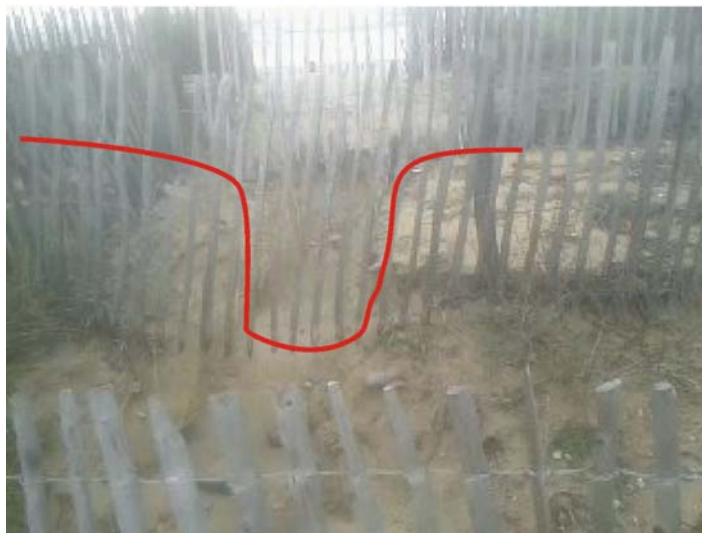
Illustration 30 – Petite brèche dans le cordon dunaire en face de la rupture de la barre interne (à la limite NE du géotextile).
