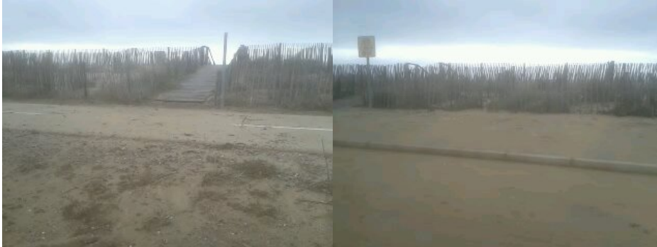
Illustration 29 - Dépôts sableux sur la piste cyclable au droit du géotextile.
