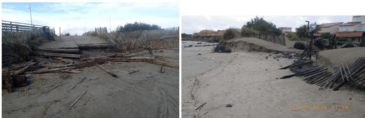
*Illustration 34 – Destructions des ganivelles et accès à Carnon (à gauche) et au Cap d'Agde (à droite).*
