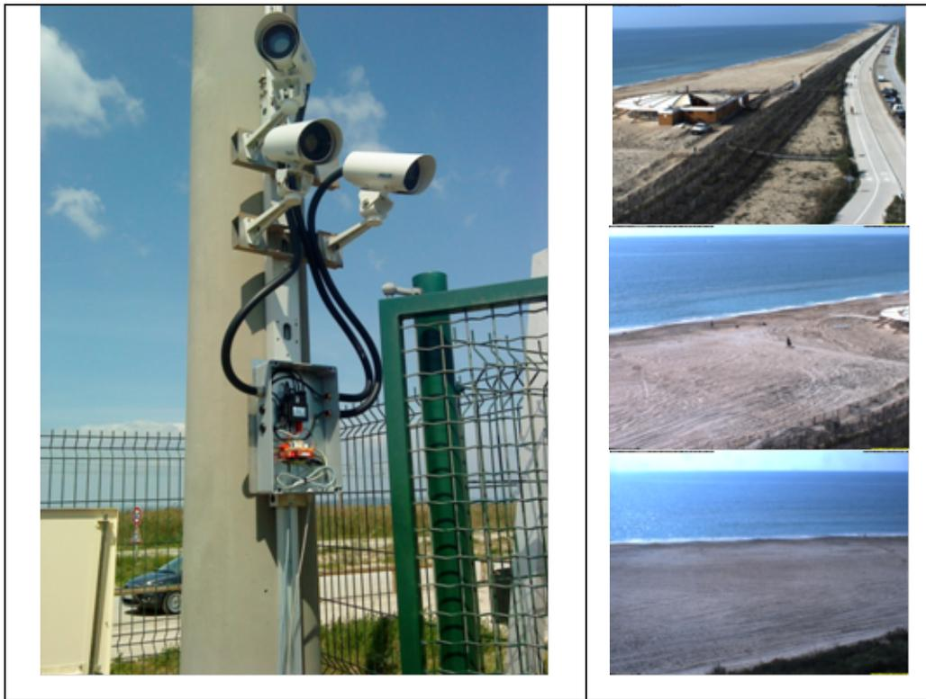
*Illustration 4 - Photos des 3 caméras (C6,C7 et C8) du mât n°1 (à gauche) et des 3 points de vue correspondants.*
